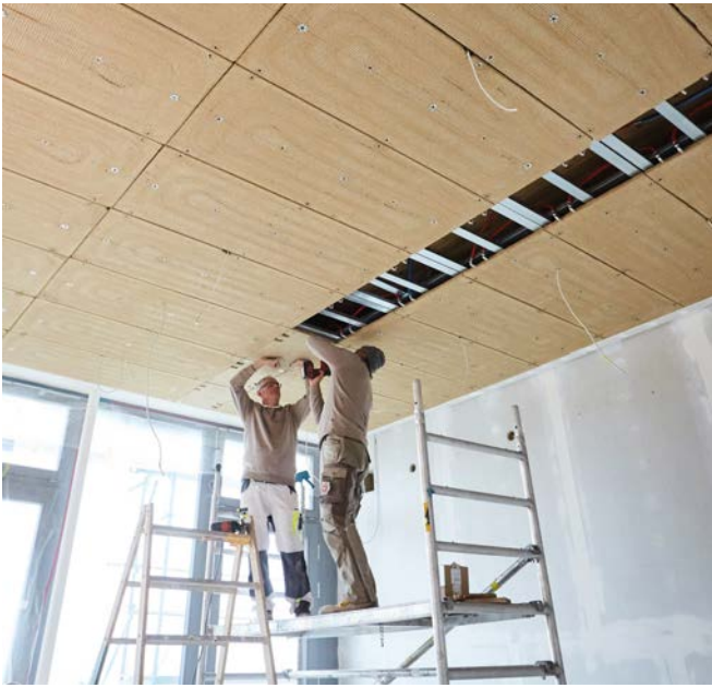
Bild 6 Verbau Klimaelemente zum Heizen und Kühlen an der Decke der Vinothek Weingut Familie Sauer
