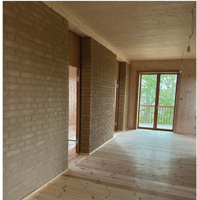
Bild 3 Forschungshaus 4, Bad Aibling – Einfach Bauen, tragende Lehmsteininnenwände
