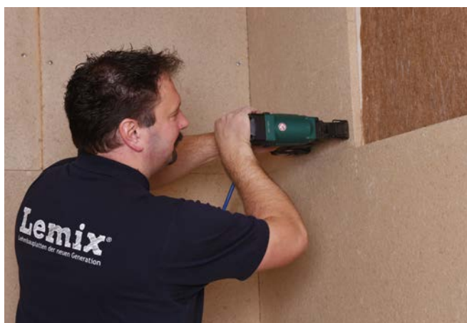
Bild 5 Verbau einer Lehmplatte (schwer)
