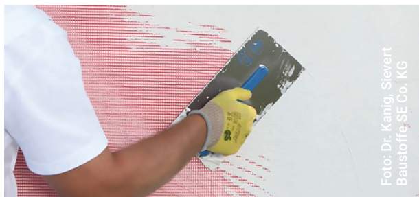
Bild 5: Vollflächiges Einbetten des Armierungsgewebes in einen Armierungsmörtel
