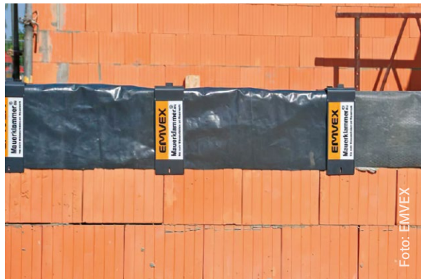
Bild 9: Schutz des Mauerwerks im Bauzustand
