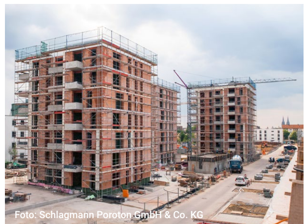
Bild 1: Homogenes Ziegelmauerwerk
