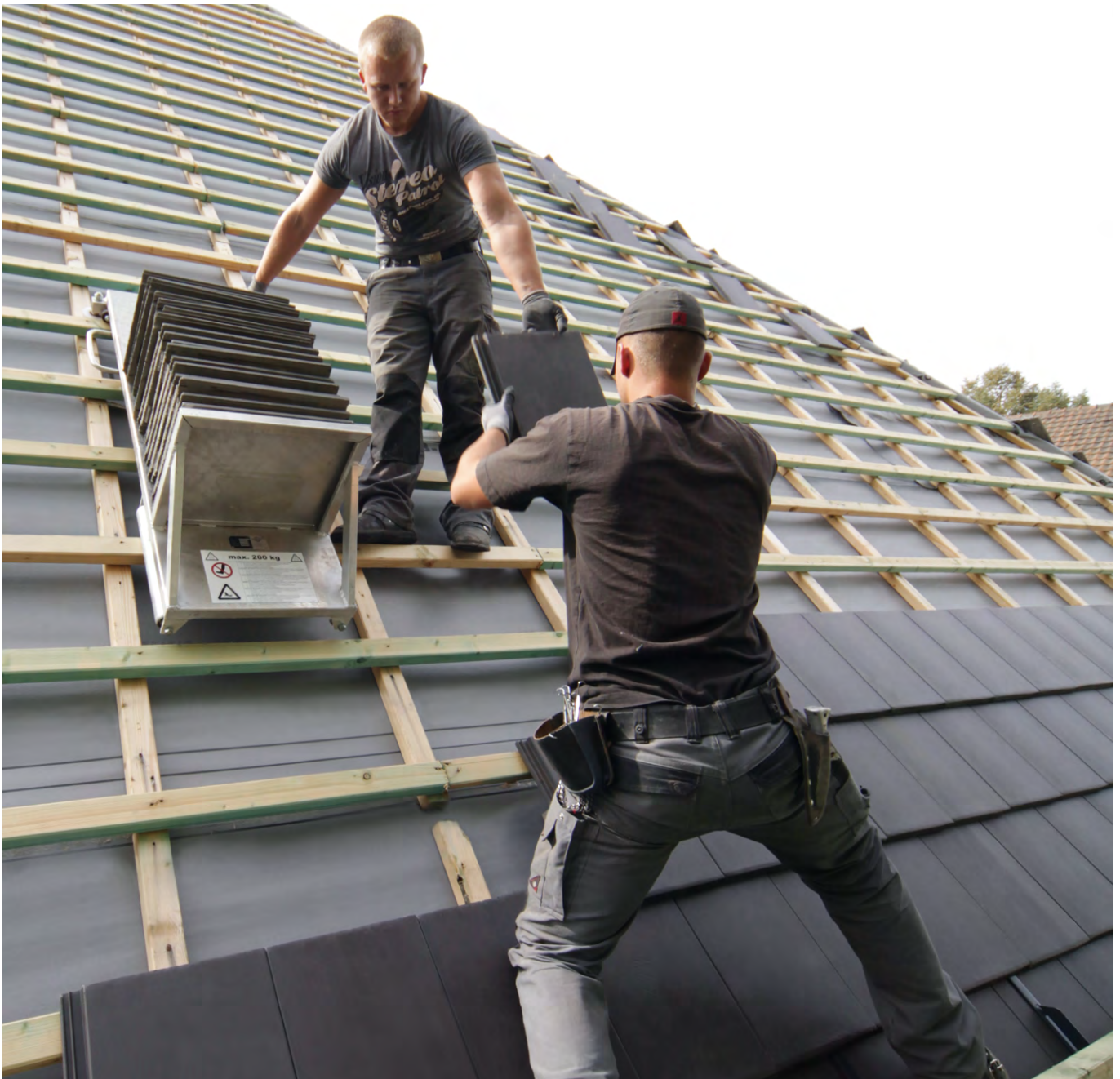
Abbildung 22: Verlegung am Dach; Quelle: BMI Steildach GmbH
